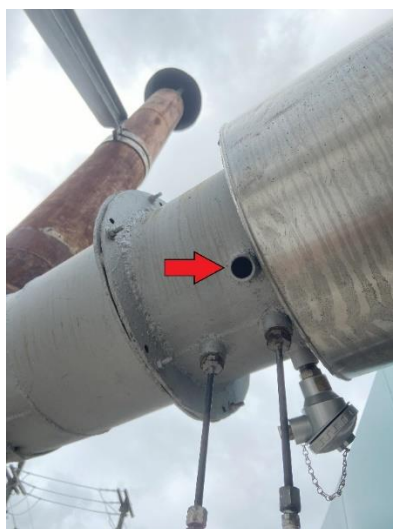
Figura 4 – Local de inserção da haste do analisador
