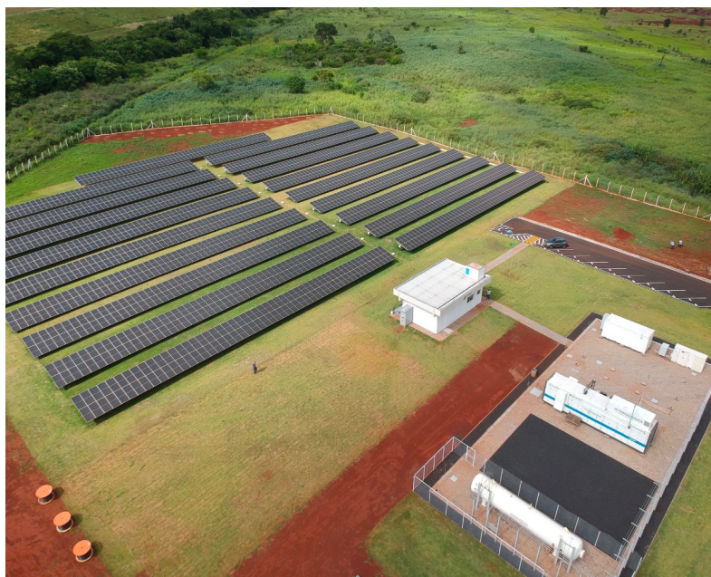
Figura 7- Planta Piloto de Hidrogênio na Usina de Itumbiara.
